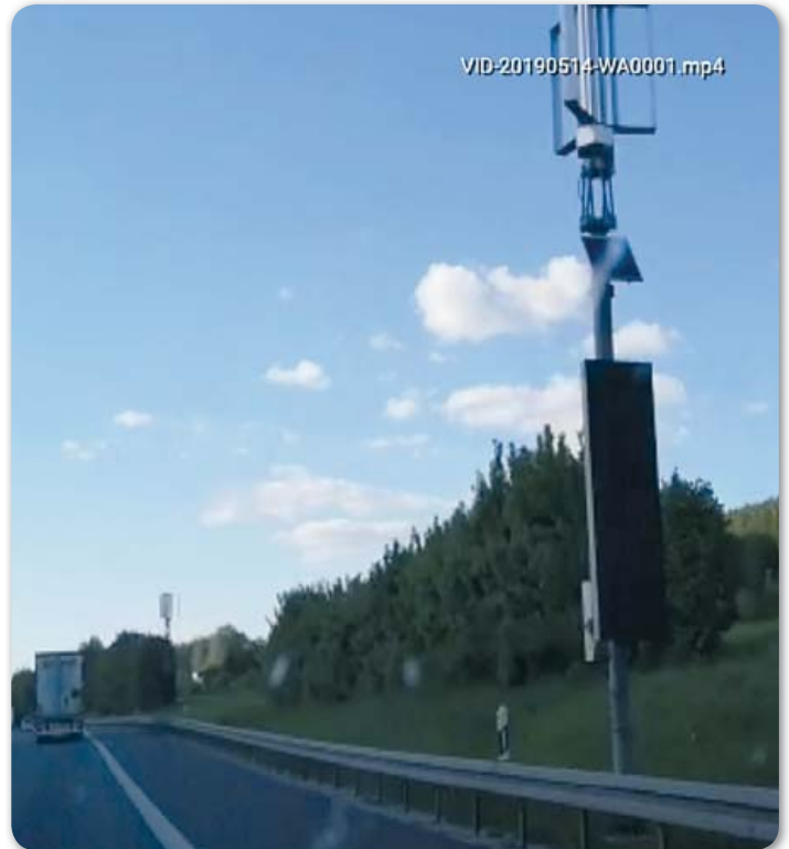
5G-Testanlage auf beiden Seiten der A9 bei Greding. Von Sender zu Sender sind es ca. 70 m.
