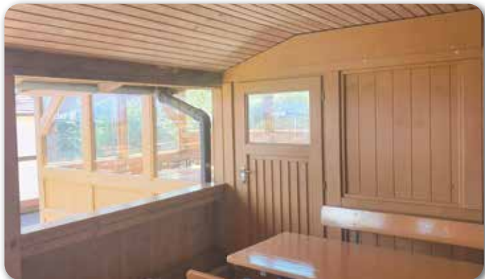
Innenansicht nach Fertigstellung
