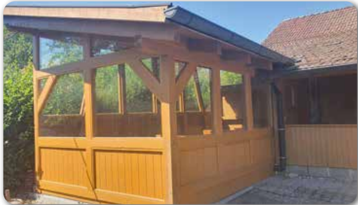
Außenansicht nach Fertigstellung
